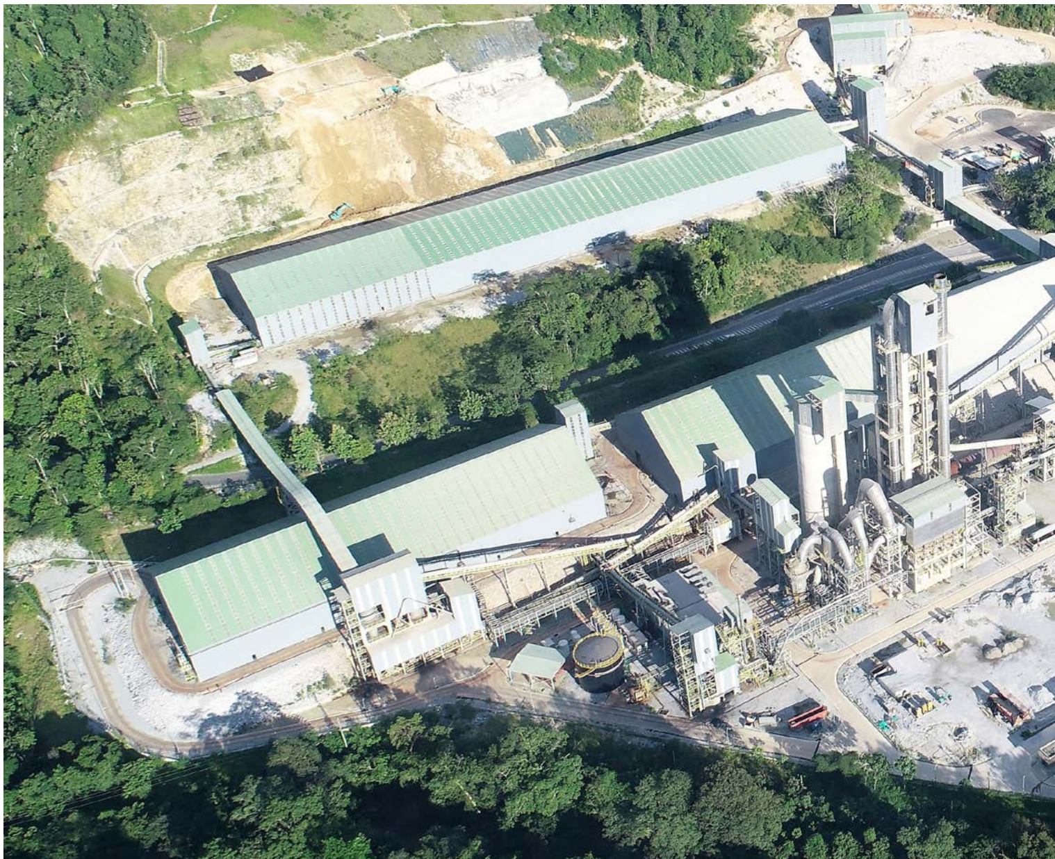
Vista aérea de la planta cementera, en Sonsón, Departamento de Antioquia. Colombia.
