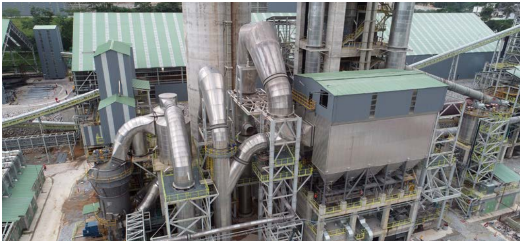
Imagen de molino de crudo y filtro principal.
