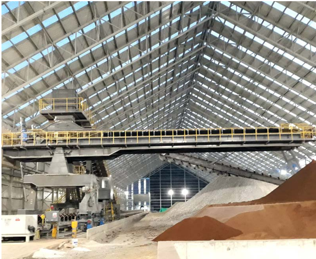
Apilador y reclamador de aditivos.
