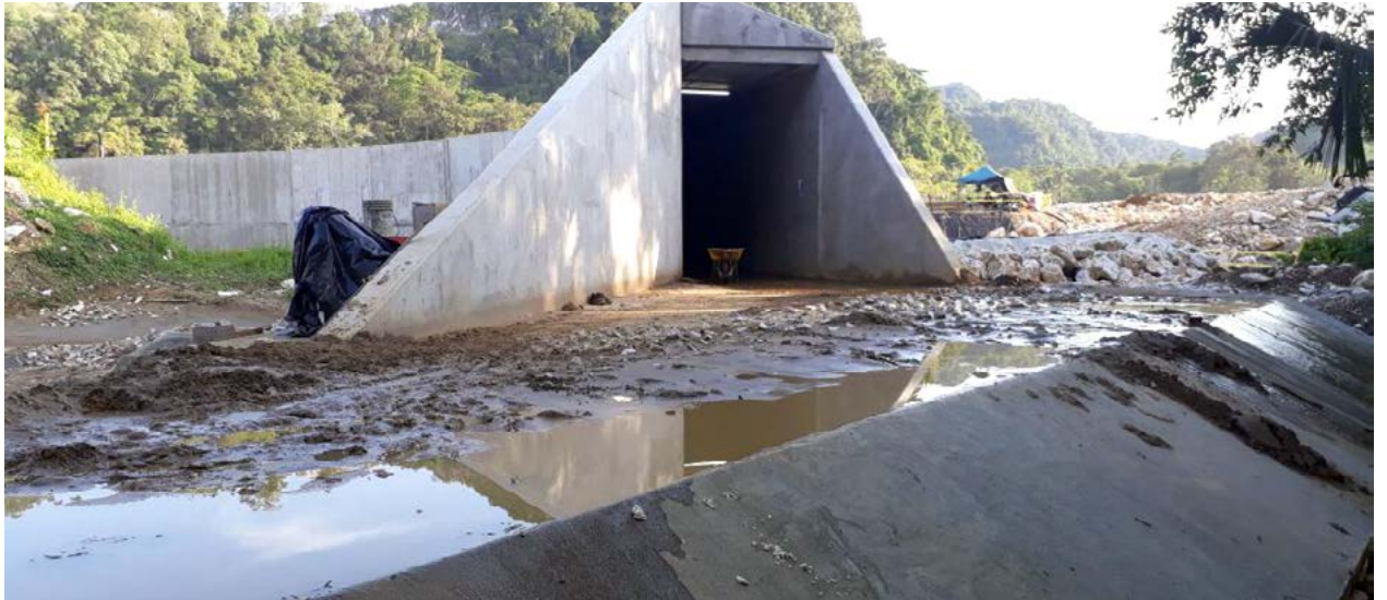
Entrada de túnel o box-couvert .
