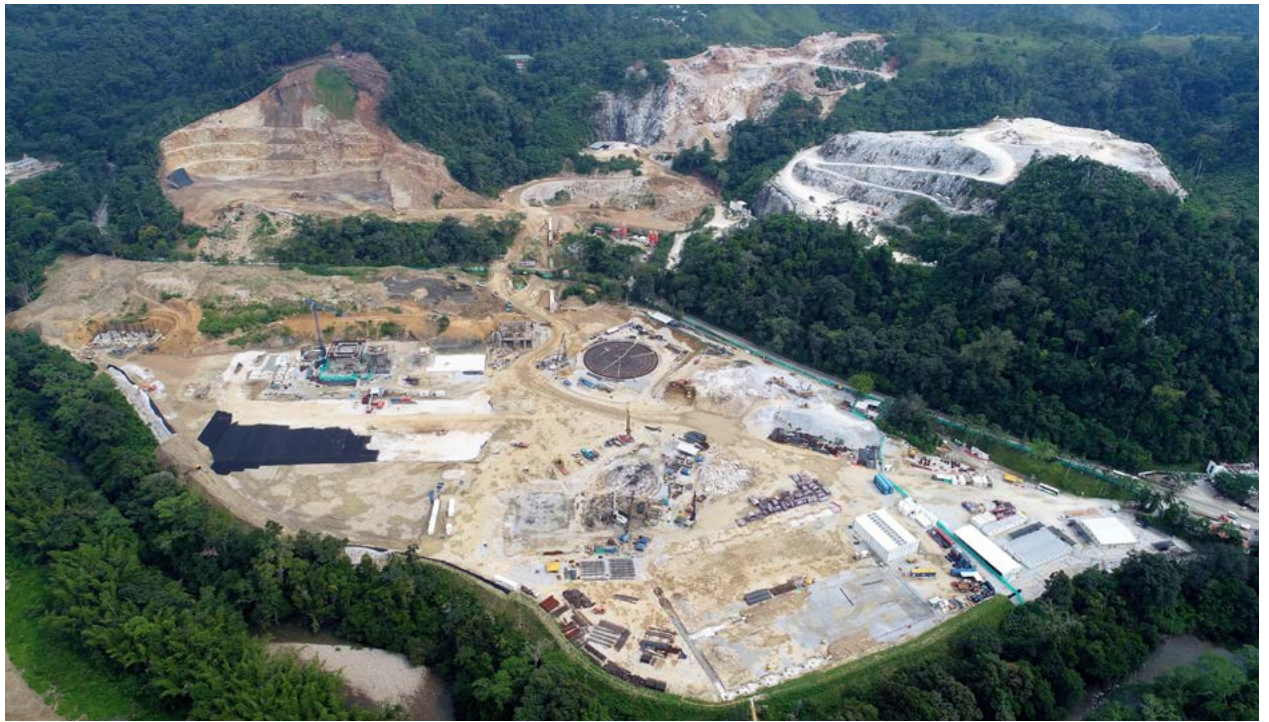
Imagen de movimiento de tierra y cimentaciones principales.
